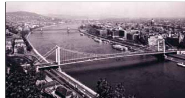
1964-ben kábelhídként épült újjá az Erzsébet híd (az Uvater felvétele)
