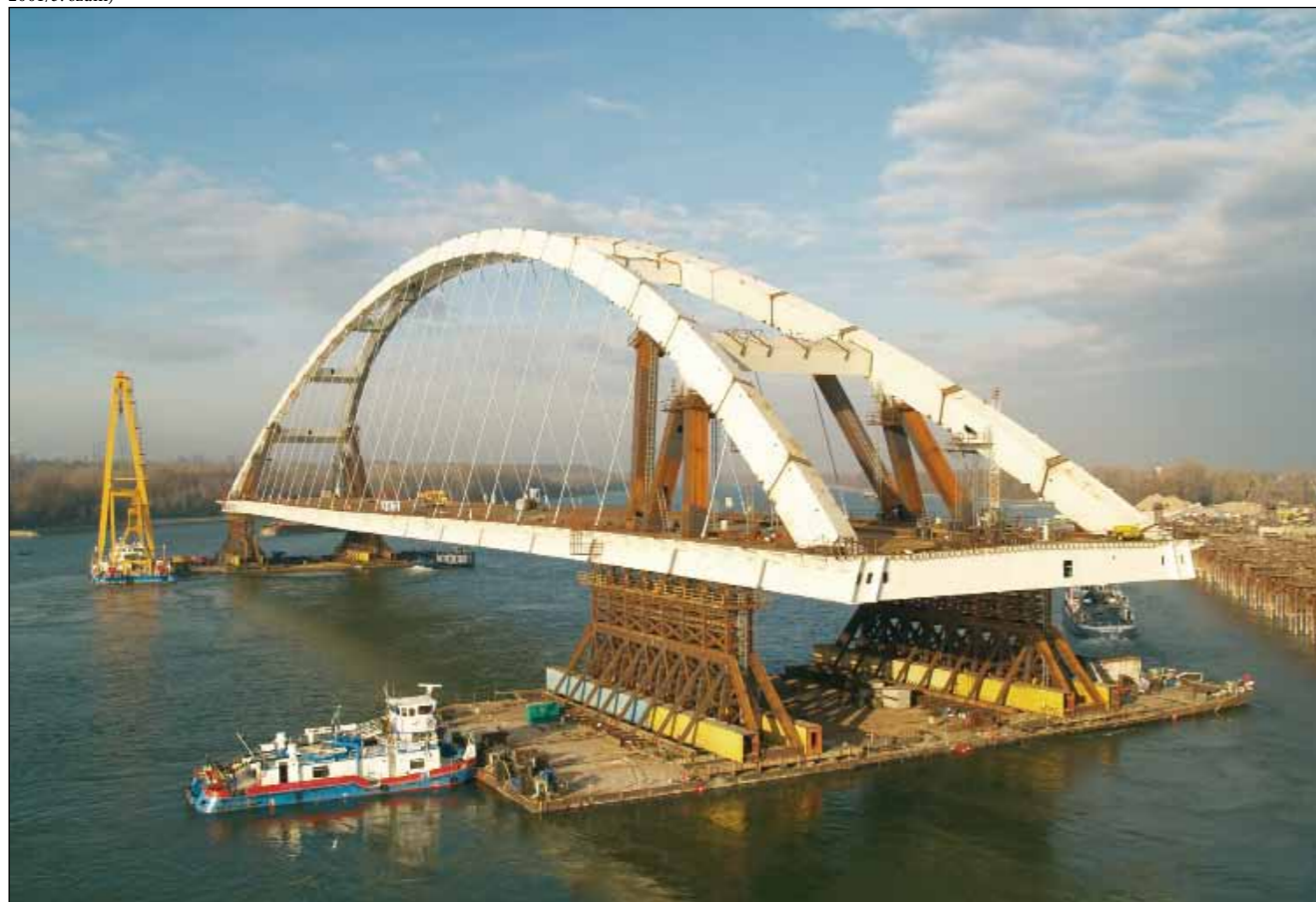
A Pentele híd mederszerkezetének beúsztatása, a hazai Duna-híd építés egyik kiemelkedő bravúra (dr. Domanovszky Sándor felvétele)
