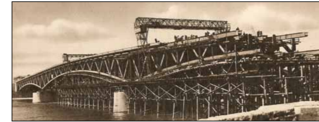
A Horthy Miklós híd szerelése állványon, 20 tonnás acél bakdarukkal, 1936. (a MÁVAG felvétele)
