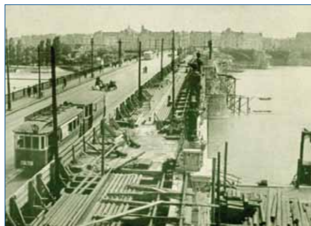
A híd szélesítése (Közlekedési Múzeum)
