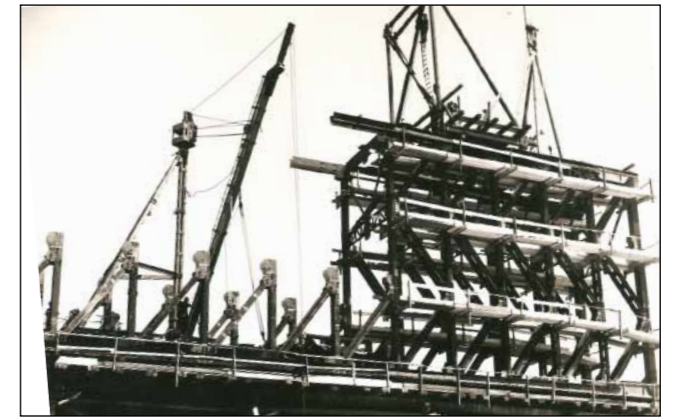
Az Északi vasúti-híd szerelése régi módszerekkel, 1954. (a MÁVAG felvétele)
