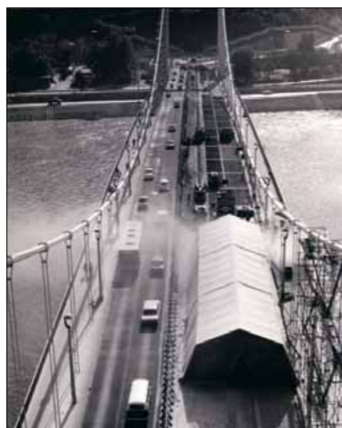
A Erzsébet híd teljes pályaburkolat cseréje különleges, nagy feladat volt (az Uvaterv felvétele)
