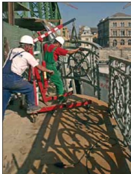
A Szabadság híd eredeti korlátjai a hídszerkezet egy részén maradtak meg. A hiányzó pótlása napjainkban megtörtént (Főmterv, Szikszay Ágnes felvétele)
