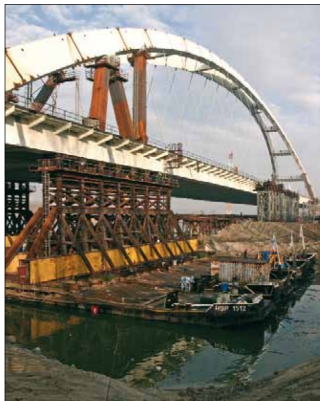
A beúsztatásra készített mederhíd (Főmterv felvétel)
