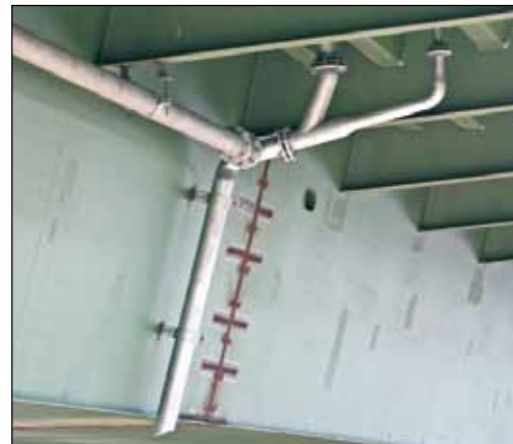
Duna-hídjaink saját közműhálózata (vízelevezetés, világítás, stb.) is rendkívül fontos (a Főmterv felvétele)
