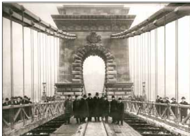
Az első Lánchíd átépítésének kezdetén, 1914. februárjában (a MÁVAG felvétele)
