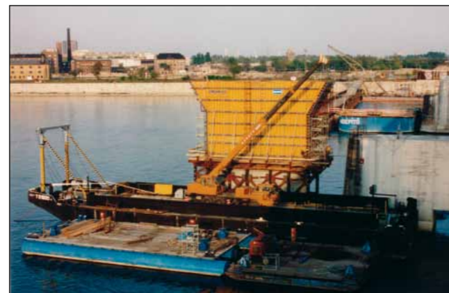
A Lágymányosi híd pillérei újszerű alappal épültek (Domanovszky Henrik felvétele)
