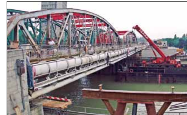
A Kvassay hídnál az átvezetett közmű kiváltása külön nagy feladat volt (a Főmterv, Szikszay Ágnes felvétele)
