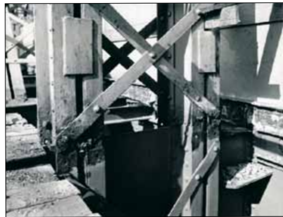
1985-ben a Szabadság híd felújítása során rendkívül súlyos korróziós kár mutatkozott. Javítása izgalmas nagy feladat volt (Közútkezelő felvétele)
