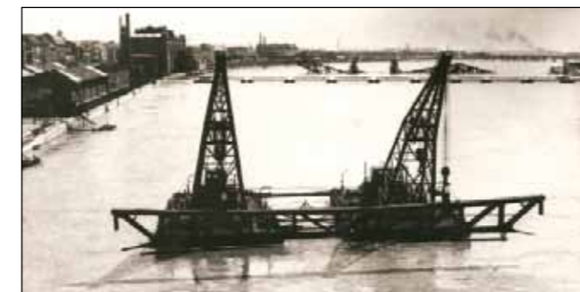
A Ferencz József (Szabadság) híd újjáépítése két 100/50 tonnás úszódaruval (1946) (a MÁVAG felvétele)
