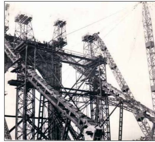
Az Erzsébet híd kapuzatának bontása bonyolult, kényes feladat volt ( a MÁVAG felvétele)
