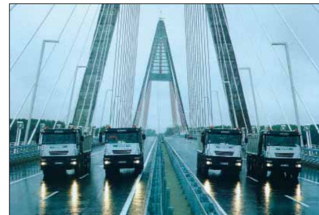
Dinamikus próbaterhelés 1. (dr. Dunai László felvétele)
