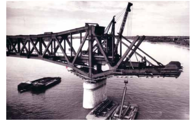
Bajánál új folytatólagos rácsos acél híd épült szabad szereléssel (MÁVAG felvétele)
