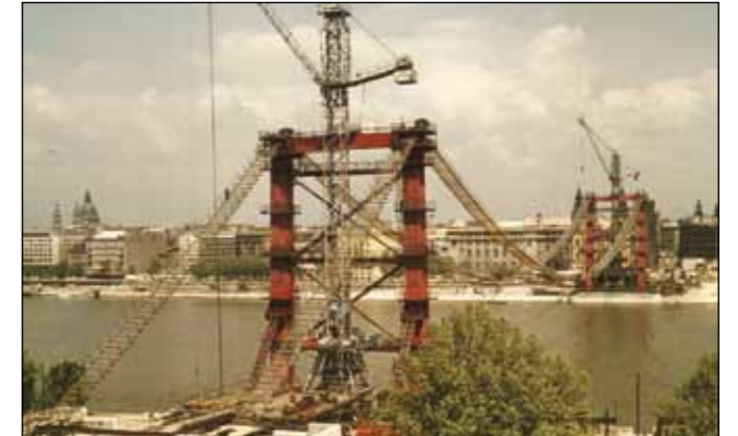
Az Erzsébet pilonjainak és parti nyílásainak szerelése 25 tonnás toronydarukkal (a MÁVAG felvétele)
