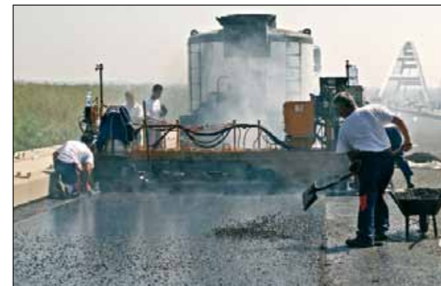
Burkolatépítés (Főmterv felvétel)
