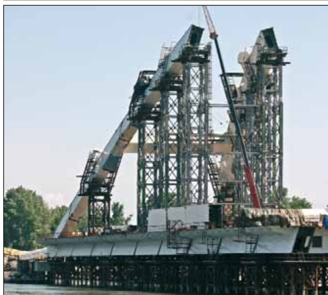
A mederhíd szerelése (Főmterv felvétel)
