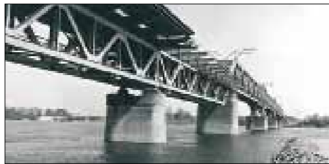
A Baja Duna-híd konzolok építése a könnyű gépkocsi forgalom részére (A Hídépítő V felvétele)
