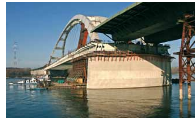
A Pentele híd világbajnok mederszerkezete a bravúros beüzemelés után (Főmterv felvétel)
