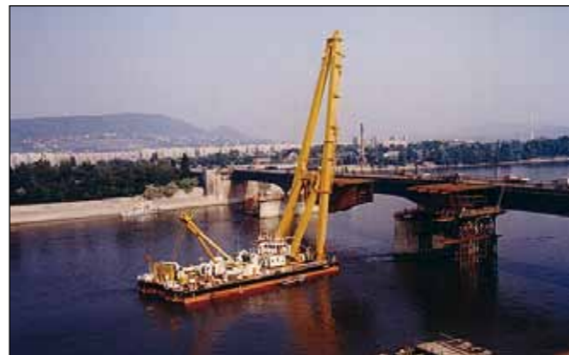
A Clark Ádám úszódaru napjainkig a Duna-híd építés vezérgépe (dr. Domanovszky Sándor gyűjteményéből)
