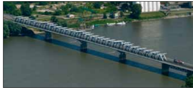
A Bajai Duna-híd konzol erősítése reális költségszintű volt (Gyukics Péter felvétele)
