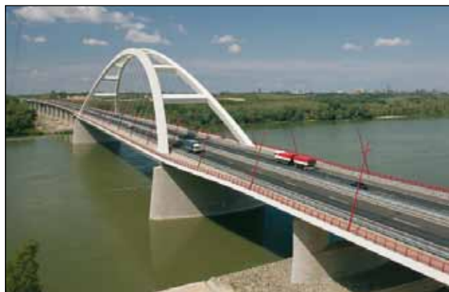
Dunaújvárosnál világcsúcs méretű nederhíddal épült meg a Pentele híd (Gyukics Péter felvétele)
