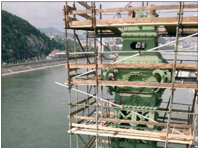
A Szabadság híd felújításánál is csőállványok biztosítják a szerkezethez való hozzáférést (a Főmterv felvétele)
