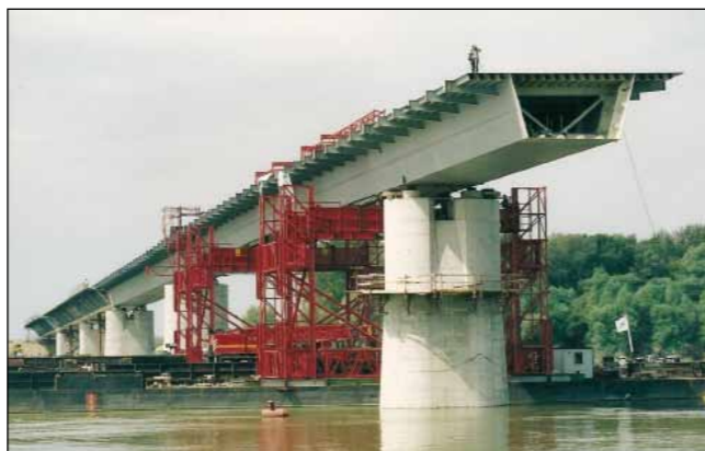
A Szekszárdi híd jobb parti szélső egységének beemelése, 2002. (dr. Domanovszky Sándor felvétele)
