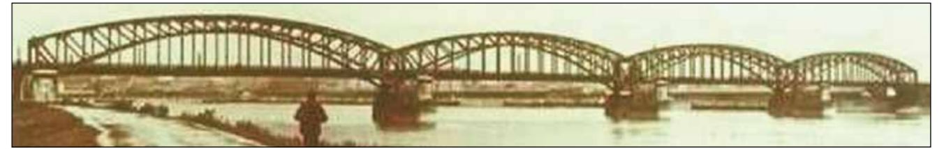
Az 1913-ban épült új kétvágányú vasúti híd (Közlekedési Múzeum)
