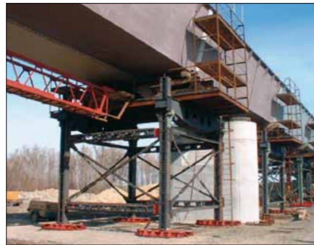
A Szekszárdi Duna-híd ártéri nyílásainak szerelő állványa (dr. Koller Ida felvétele)
