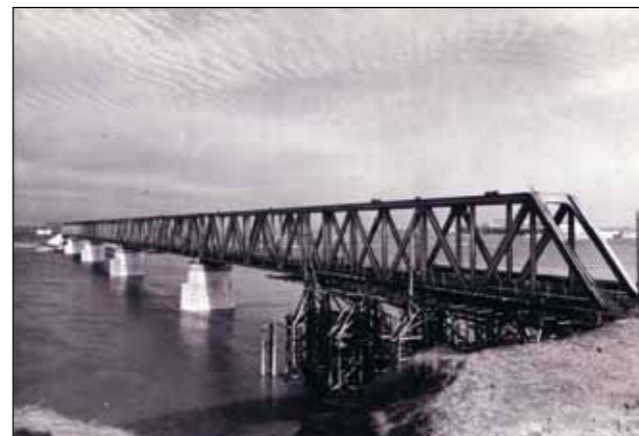
Komárom vasúti hídjának újjáépítése (KKK archívum)
