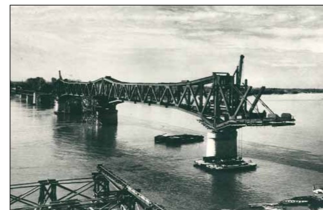
A híd újjáépítése (MÁVAG felvétel)
