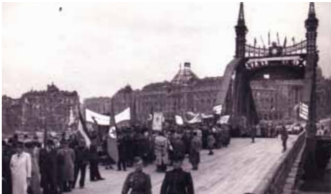
A volt Ferenc József híd roncsaira szükség híd épült különleges megoldással (a középső hídnylásban úszó aljzattal) (KKK gyűjtemény)
