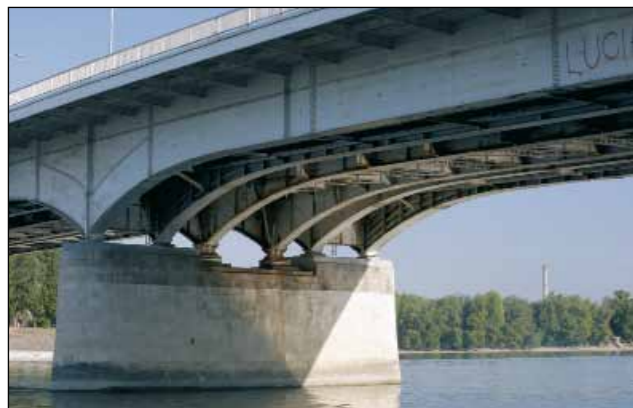
Az 1950-ben korlátozott szélességgel megépített Árpád híd két korszerű hídrésszel bővült 1981-84 között (Gyukics Péter felvétele)
