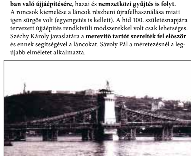
A Lánchidat roncsaiból 100. születésnapjára építették újjá. A munka gyorsítására a láncszerelés a merevítőtartóról történt (a MÁVAG felvétele)
