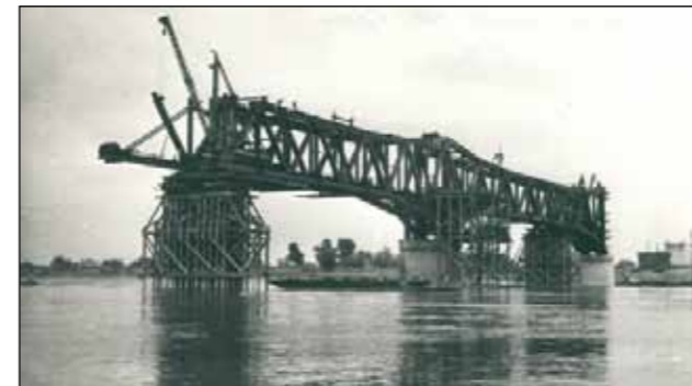
Bajánál teljesen új, folytatólagos, többtámaszú hídszerkezet épült szabadszereléssel (a MÁVAG felvétele)
