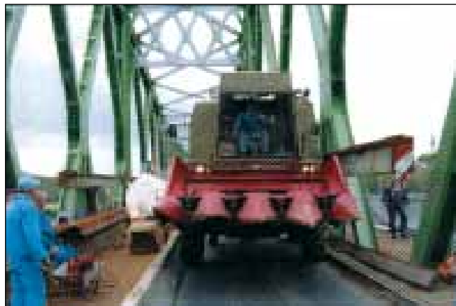
Dunaföldváron a közúti forgalom fenntartása mellett épült át a teljes pályaszerkezet (Rigler István felvétele)
