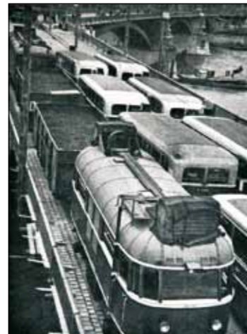
A Margit híd újjáépítéskori próbatárhelése (dr. Széchy Károly nyomán)
