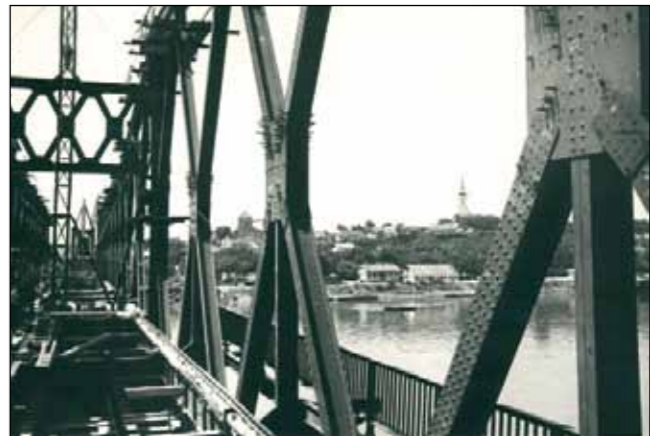
Dunaföldvárnál új, rombikus rácsoszású Duna-híd épült, 1951 (a MÁVAG felvétele)
