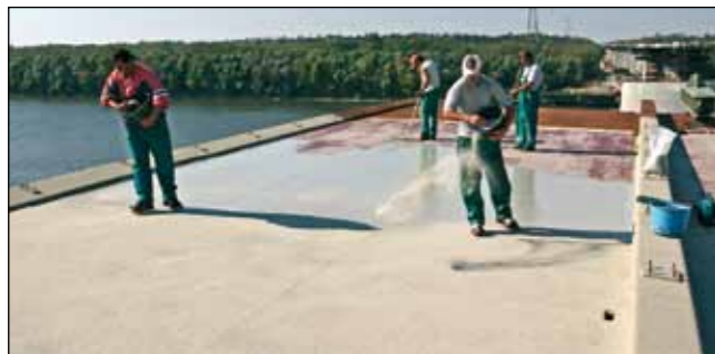
Pentele acélpályalemezeinek szórt műanyag szigetelése készül (a Főmterv felvétele)
