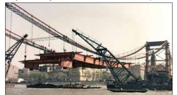
100 tonnás pályaelemek beemelése két úszódaruval, 1964. (a MÁVAG felvétele)
