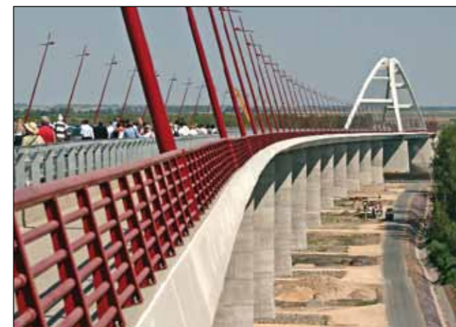
A híd a hosszú ártéri rész felől (Főmterv felvétel)
