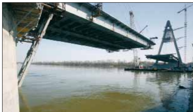
Első ferdekábeles Duna-hidunk szabadsszereléssel épült (Gyukics Péter felvétele)
