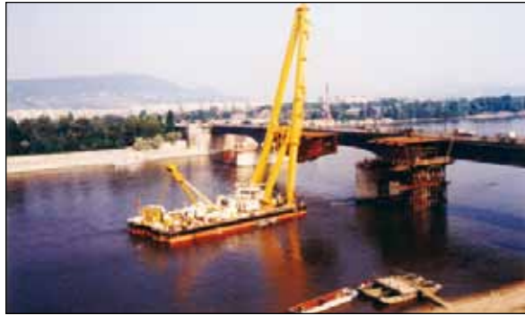
Az Árpád híd kapacitásbővítése 1984-ben (Közlekedési Múzeum)
