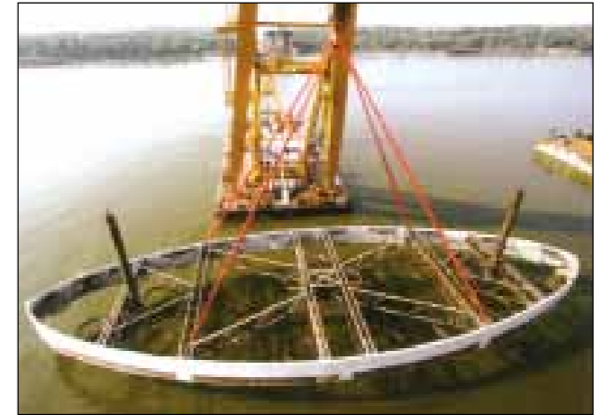
Dunaujvárosnál az alapozási munkák hatalmas kéregelemekkel készültek (Csécsai Pál felvétele)
