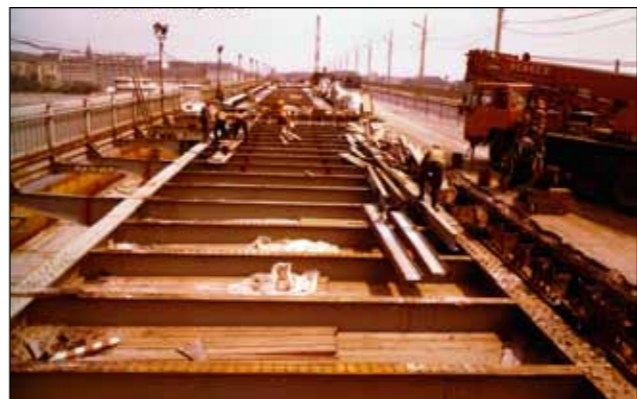
A Petőfi híd felújítása az átfogó Duna-híd felújítási program keretében történt (a Hídepítő Vállalat felvétele)
