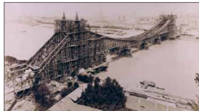
Az épülő függőhíd (MÁVAG felvétel)
