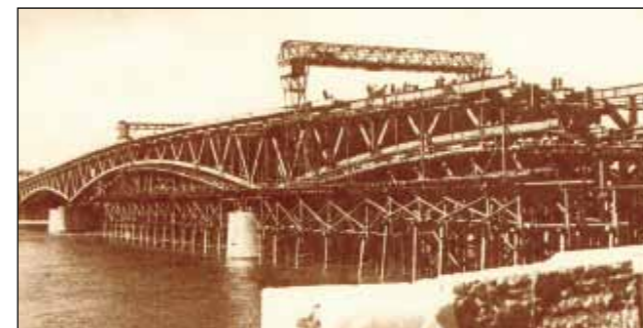
A Boráros térenél épült felsőpályás gerendahíd a Nagykörút forgalmának átvezetésére 1937-ben (Közlekedési Múzeum)
