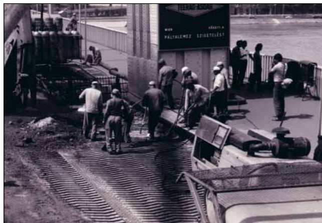
Az ortotrop pályalemez Erzsébet híd aszfalt burkolata nehéz fenntartási feladatot jelentett. Különösen 1975-ben (az Uvaterv felvétele)
