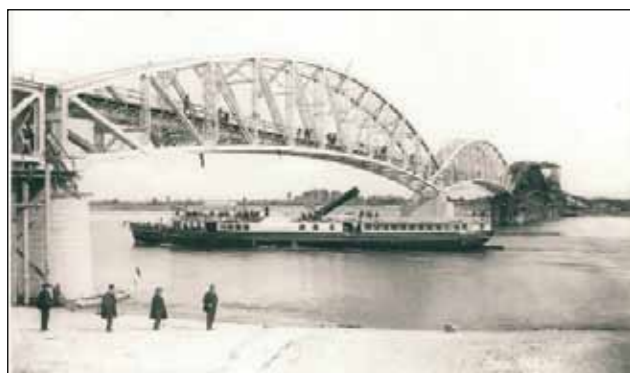
Bajánál is sarló alakú rácsos vasúti híd épült. A kép még építés közbeni állapotot mutat (1908., MÁVAG archivum)
