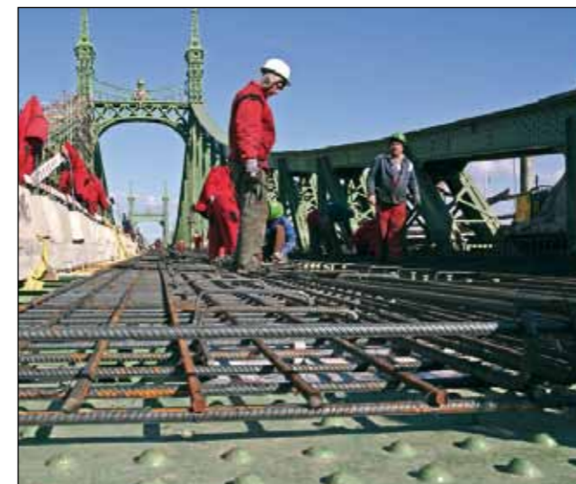
Felújítás 2008-ban (Főmterv felvétel)
