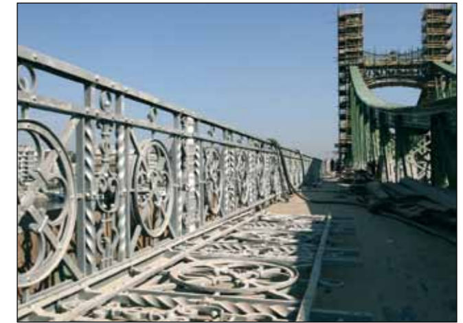
A korlátok átépítése (Főmterv felvétele)
