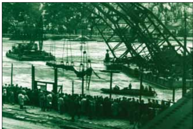
Az Erzsébet híd láncainak kiemelése úszódaruk munkájával (Közlekedési Múzeum)
