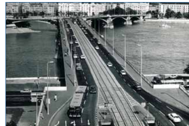
A felújított híd 1978-ban (Uvaterv felvétel)
