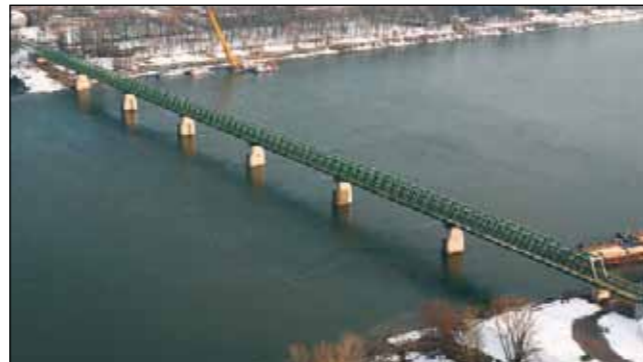
Az Északi, Újpesti vasúti híd átépítés után, 2009-ben
