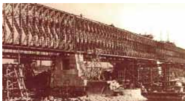
A Déli Összekötő vasúti hídnál ideiglenes hadihíd szerkezet (K híd) épült (Közlekedési Múzeum)
