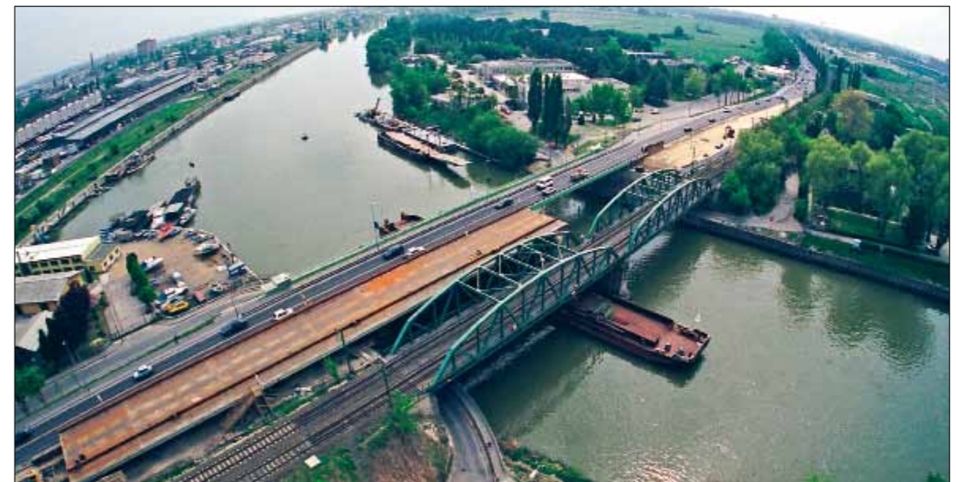
Az új hídrész betolása, az új híd alulnézetben, az elbontott híd emléke (Főmterv Szikszay Ágnes felvételei)
