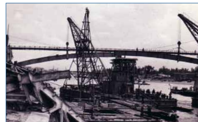
A híd újjáépítése (KKK gyűjtemény)
