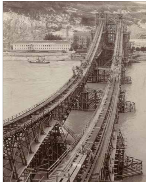
Az Erzsébet híd láncainak szerelése állványon. 1901. (a MÁVAG felvétele)
