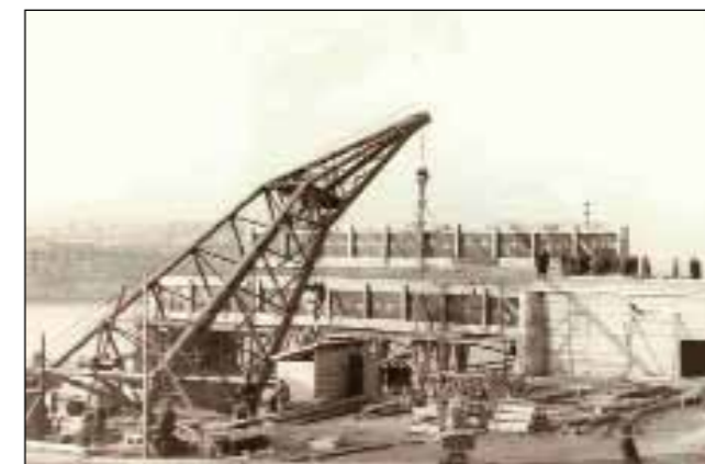
A bevezető nyílás építése
