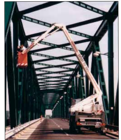
A Medvei Duna-hídon a hídpálya alatti részek vizsgálata külön szerkezettel, a hídpálya felett vizsgáló gépkocsival történik
