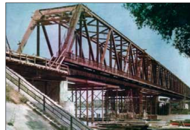
A végleges újjáépítés 1970-73. (a Hídépítő V. felvétele)
