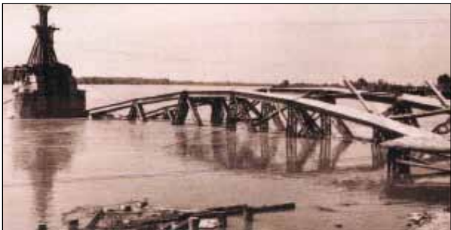
Bajánál egyedül álló módon a pillérekre épített kábelhíd szolgált a Duna két partja közti szállításra (KKK gyűjteménye)
