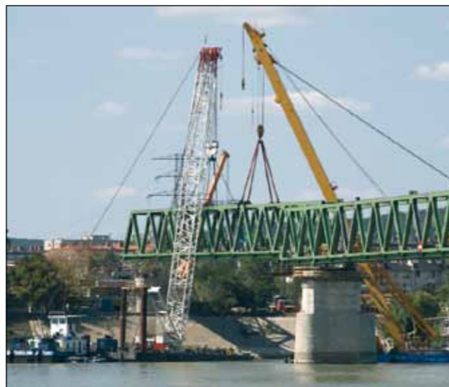
Az Északi vasúti híd utolsó szakaszának beemelése két úszódaruval a budai hídfőnél, 2008. (dr. Domanovszky Sándor felvétele)
