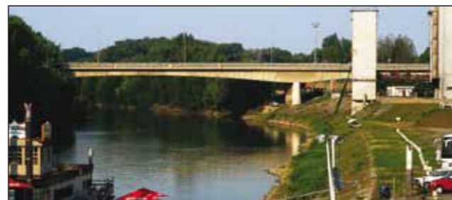
Győrben 1979-ben elkészült első szabadon betonozott technológiájú Mosoni-Duna-híd, a híd napjainkban (Gyukics Péter felvétele)
