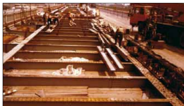
A híd felújítása (a Hídépítő V. felvétele)
