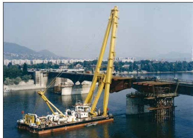
AZ Árpád híd bővítése a 120 t emelőkapacitású Clark Ádám úszódaruval, 1981. (a MÁVAG felvétele)
