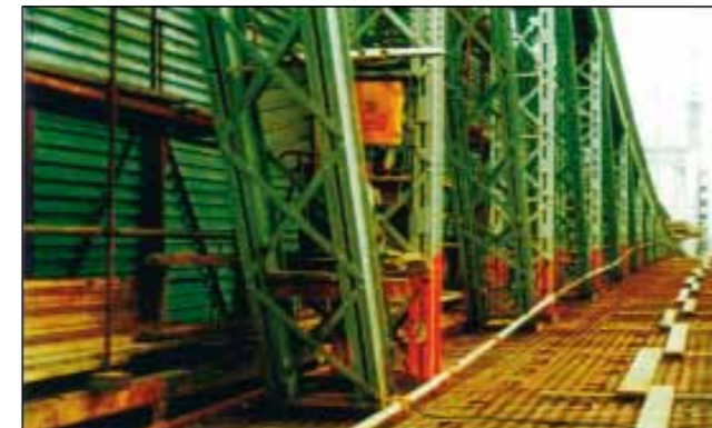
A híd felújítása 1985-86-ban (a Hidépítő Rt. felvétele)
