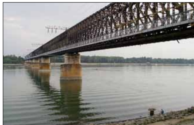
Az Északi, Újpesti vasúti híd K hadihíd szerkezettel épült és 53 évig szolgálta a forgalmat (Gyukics Péter felvétele)
