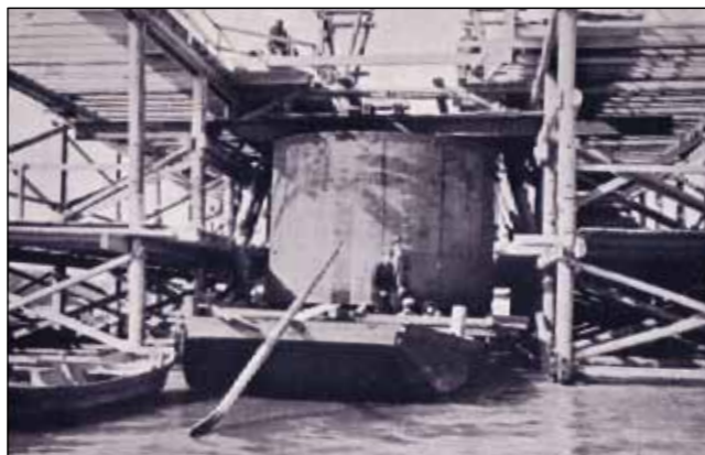
„Caisson beúsztatása a munkahelyre” (Építési album)
