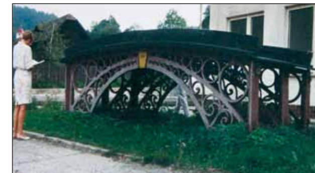
Első vashidunk 1810-ben épült (Kiskőrösi Közúti-Szakgyűjtemény)
