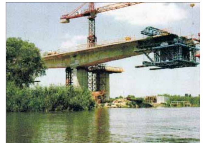
Építés közben (Atadási füzet)
