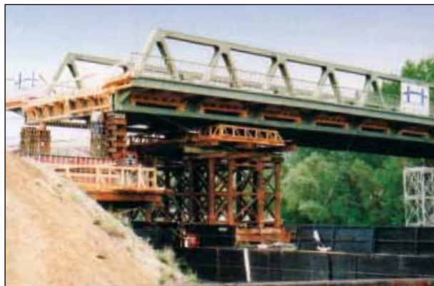
Taksonynál az új Duna-ág-híd beúsztatással került a helyére (a Hídépítő Rt. felvétele)
