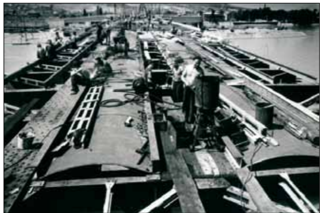
Az Árpád híd dongalemezes pályaszerkezete (a MÁVAG felvétele)
