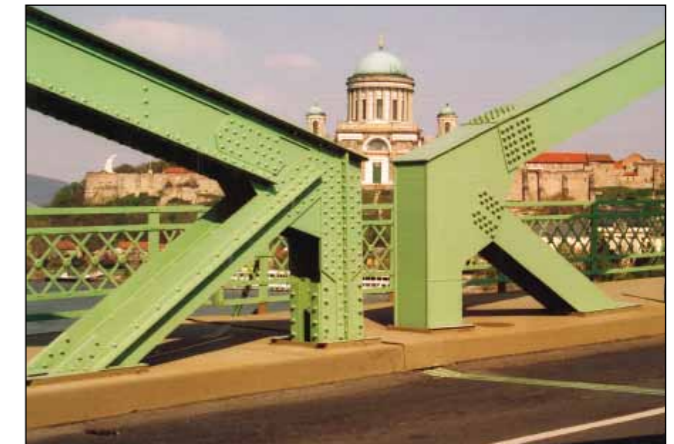
A régi és új szerkezet az újjáépített hídon
