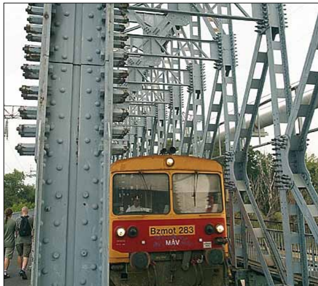
Az Északi, Újpesti vasúti híd K szerkezete a csavarokkal (Gyukics Péter felvétele)
