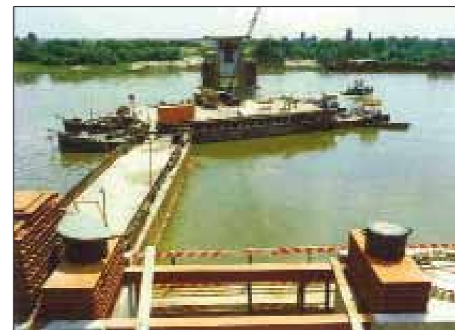
A pillérek építése (Hídépítő V. felvétele)
