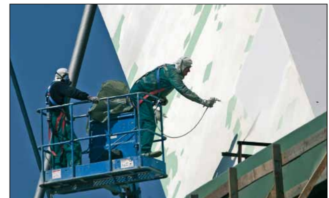
Pentelelénél a készre mázolt hídszerkezeten javítási munkákat kellett végezni (Főmterv, Szikszay Ágnes felvétele)
