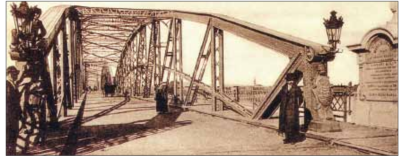
Az elkészült híd korabeli képeslapon (Kiskőrösi Közúti Szakgyűjtemény)
