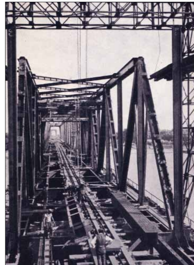
„A jobb part melletti nyílás szerelése” (Építési album)
