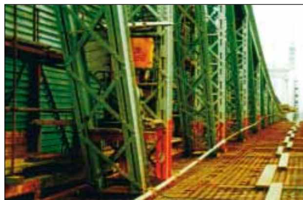
A Szabadság híd felújításának második ütemében súlyos korróziós kár jelentkezett. A javítás a BME közreműködésével történt meg (a Hídépítő Vállalat felvétele)
