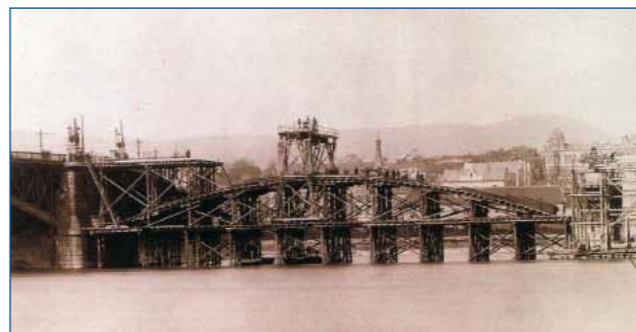
A szárnyhíd építése (Mávg felvétel)
