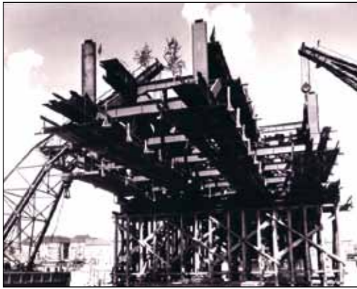
A Boráros téri híd újjáépítése (KKK archivum)
