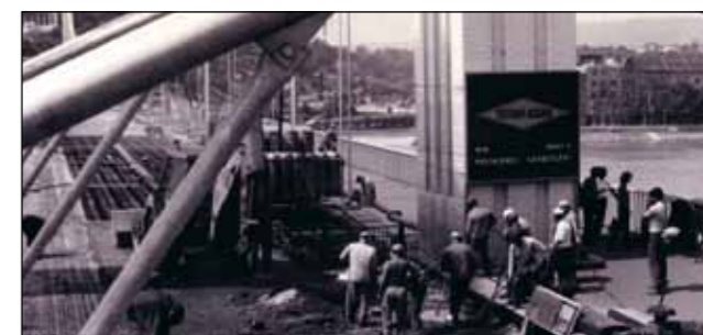
A burkolat átépítése, 1975. (Uvaterv felvétel)
