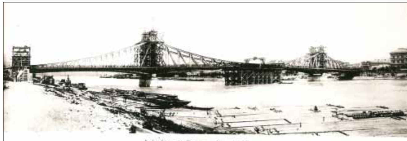
A Ferencz József híd befüggesztett részének szerelése állványon (1896.) (a MÁVAG felvétele)
