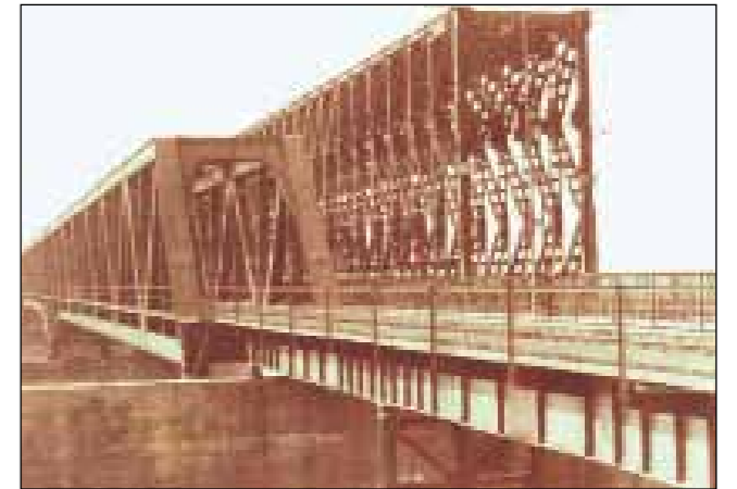
1945 után épített K és a végleges egy vágányú szerkezet (Közlekedési Múzeum)
