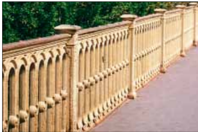
A Margit híd korlátja a szárnyhídon, eredetileg az egész hídon ilyen volt (KKK gyűjtemény)
