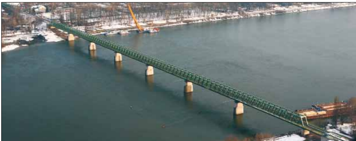
Az Északi, Újpesti vasúti-híd 53 év után három hónapos vágányzár alatt átépült (Gyukics Péter felvétele)
