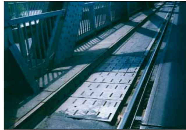
A közúti-vasúti forgalmú Bajai Duna-hídat még az 1990.-es években több alkalommal foltozni kellett (Közútkezelő felvétele)
