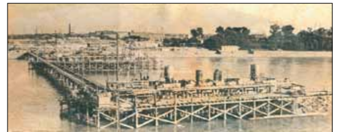
Megkezdődöttek a z Árpád hid alapozási munkái (Közlekedési Múzeum)
