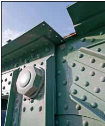
A Szabadság híd Gerber csuklója (a Főmterv felvétele)
