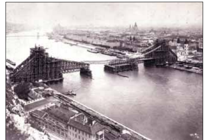
Az Erzsébet lánchíd építéséhez hatalmas állványszerkezetre volt szükség (a MÁVAG felvétele)
