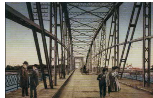
Képeslap a híd átadására Közútkezelő gyűjteménye)
