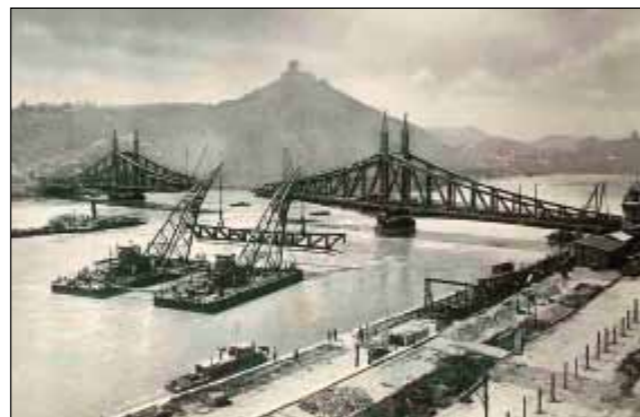
A híd újjáépítése (Közlekedési Múzeum)
