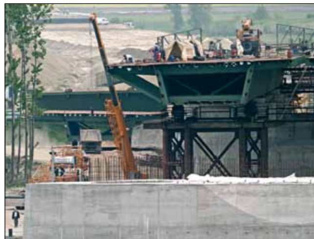
Az ártéri híd szerelése (Főmterv felvétel)
